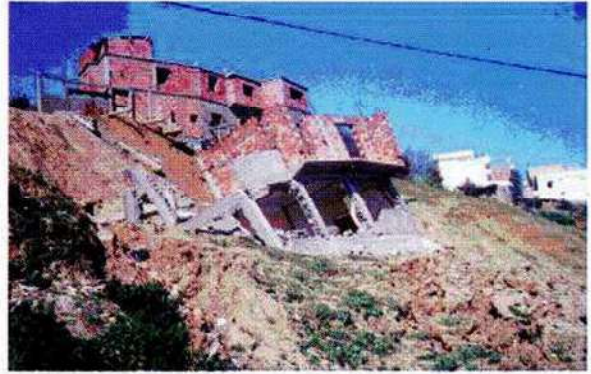
Figure 1 : Glissement de Tizi au niveau de l'ancienne carrière (Hauteurs de la ville de Béjaia)
